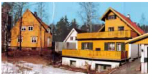
KONFLIKT - Volum og form - Den nye villaen til høyre har et oppløst bygningsvolum og skjevt røstet tak som sammen med fremskutte etasjer er i konflikt med de enkle nabohusene med saltak. En halvt nedgravd undertetasje er fremmed for strøket og vitner om dårlig terrenntilpasning. Materialer, detaljer og farger - Tilpasning ved hjelp av farge og materialbruk demper ikke konflikten.
