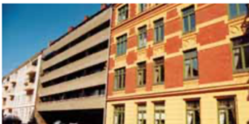
KONFLIKTFYLT KONTRAST - Volum og form - Blokken følger bebyggelsen i gaten med samme gatelinde og gesimshøyde. Skråttstilte balkongbrystninger gir en åpen, oppløst fasade med kraftig horisontal betoning. Bygget står i konflikt med de eldre bygårdenes massive, dekorerte fasader med vertikalt preg. Materialer, detaljer og farger - Materialer og farger er fremmed for strøket.
