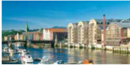
SAMSPILL - Volum og form - Det nye hotellet til høyre slutter opp om det opprinnelige bryggemønsteret med variasjoner i høyde og bredde. Materialer, detaljer og farger - Materialbruken er moderne med glass og betong og er hensiktsmessig teknisk og funksjonelt. Betongen er imidlertid farget for å spille sammen med de malte trebyggene. (Foto: Aune Forlag)
