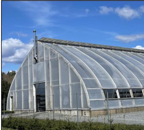
Figur 73 Naturlig ventilasjon gjennom åpne takvinduer og sidevinduer [1].
