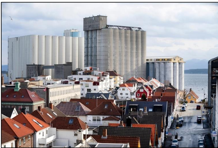
Figur 38 Silo Stavanger øst [3].
