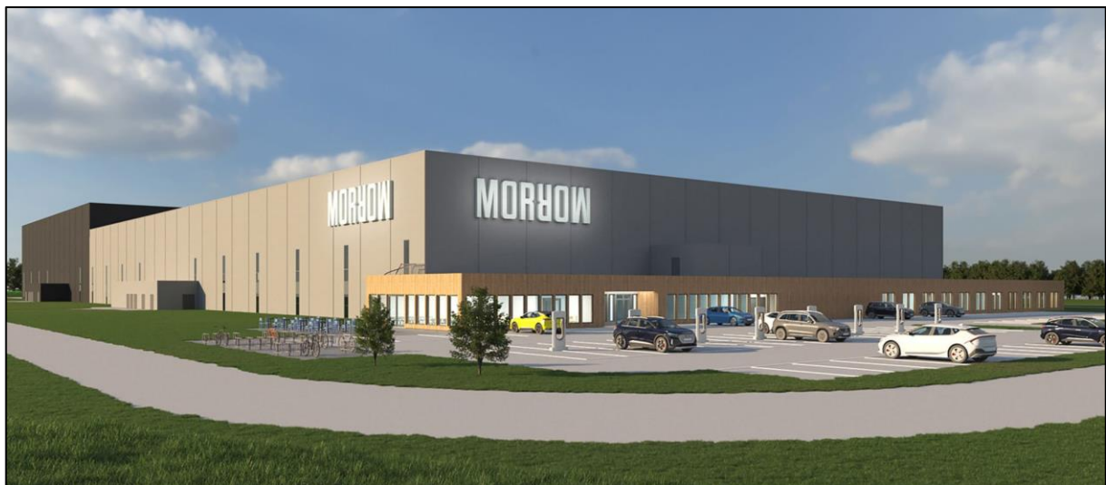
Figur 34 Morrow batterifabrikk Arendal [193].
