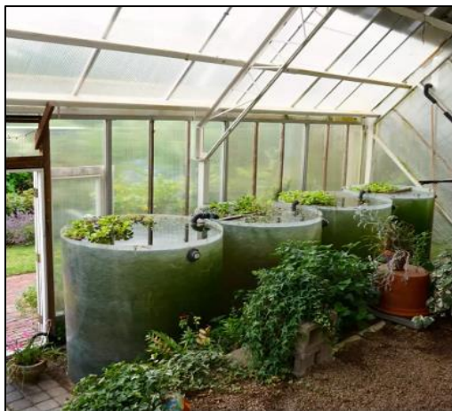
Figur 78 Vanntanker til oppvarming i drivhus [44].
