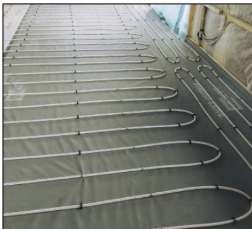
Figur 85 Vannbåren varme – Rør [28].
