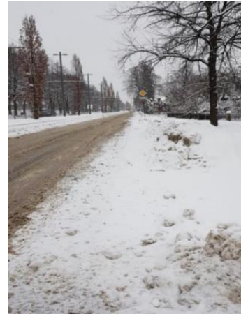
Figur 13 Bilde av Ikke bar asfalt [46]
