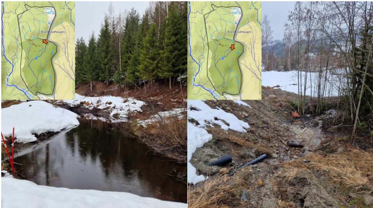
Figur 7.10 – Større vannansamling og rør
