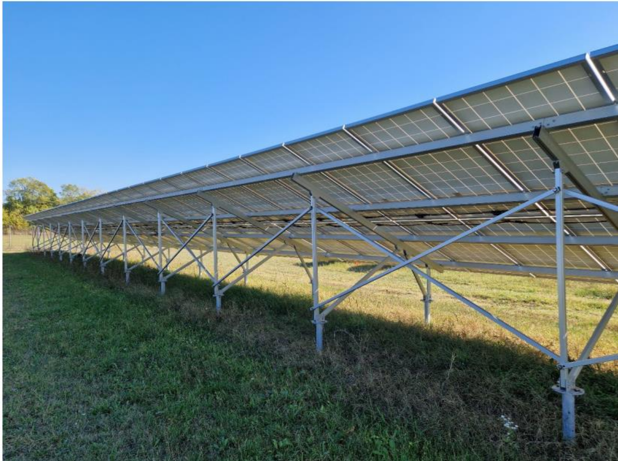
Figur 5.6 Eksempel på bakkemontert montasjesystem festet med jordskruer [40]
