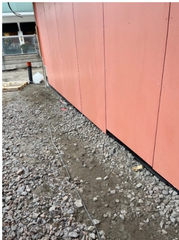
Figur 5-21 Monterte plater før kutting
