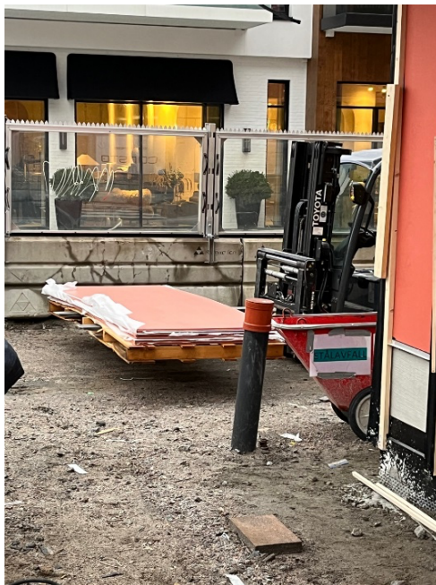
Figur 5-26 Fasadeplater fraktet med gaffeltruck
