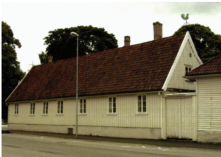
Bilde 2 Dette huset, fra 1710, på hjørnet Stener Heyerdahls park og Tordenskjoldsgate, er den delen av Kristiansands hospital som rommet dårekisten/dollhuset. (Foto: se fotnote 19)
