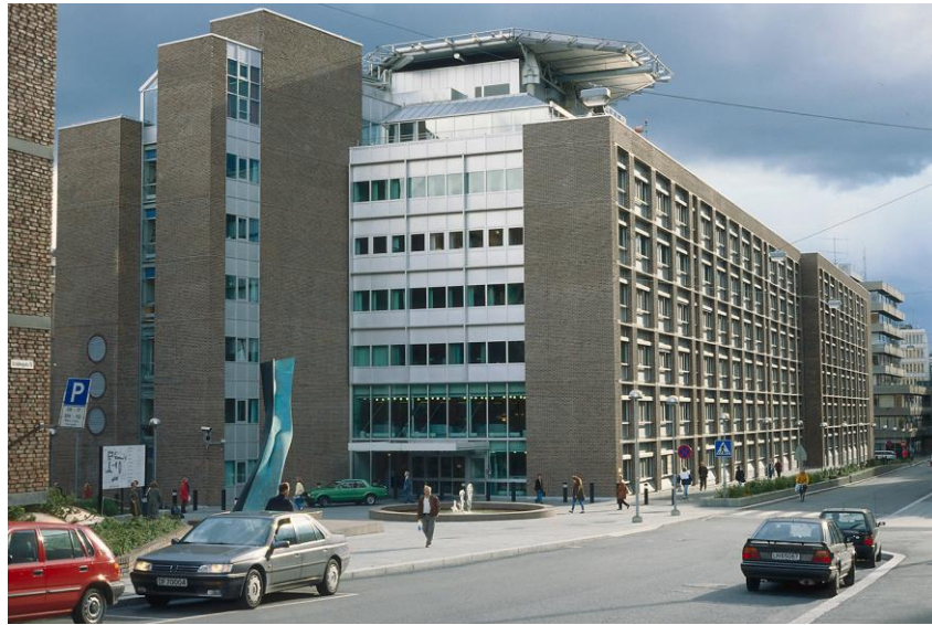
Figur 5.2: Fotografi av R4-bygget [60].
