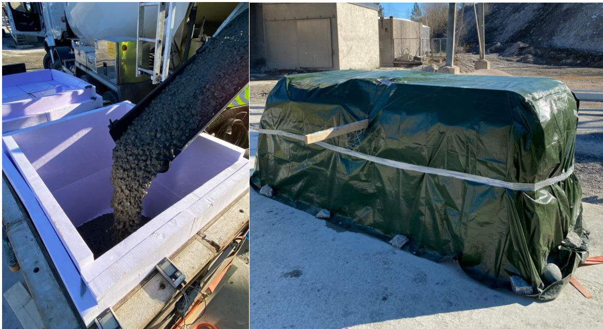
Figur 6.5: 1m 3 herdekasse utstøping ved Nenset fabrikk.
