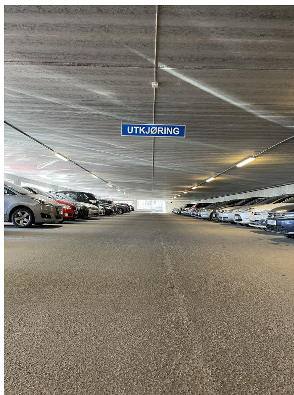
Figur 6.6: Parkeringskjelleren under i4Helse-bygget på dagtid. Foto: Privat
