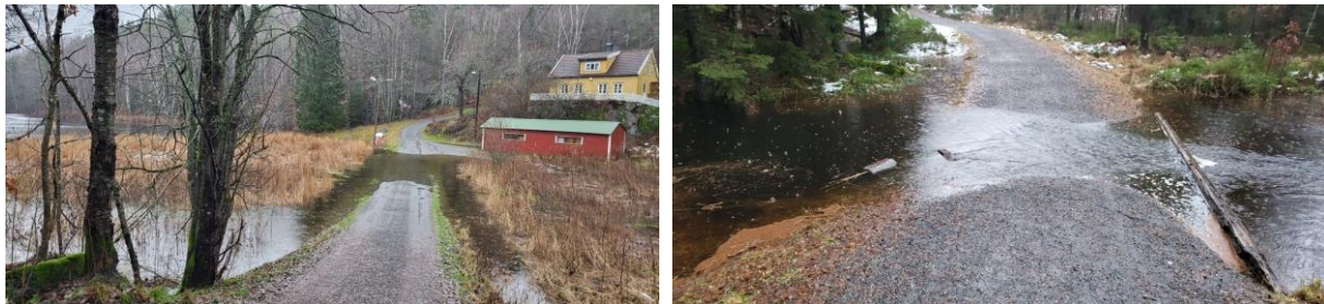
Fig. 1.1 – Oversvømmelse etter snøsmelting og regnhendelser [privat]
