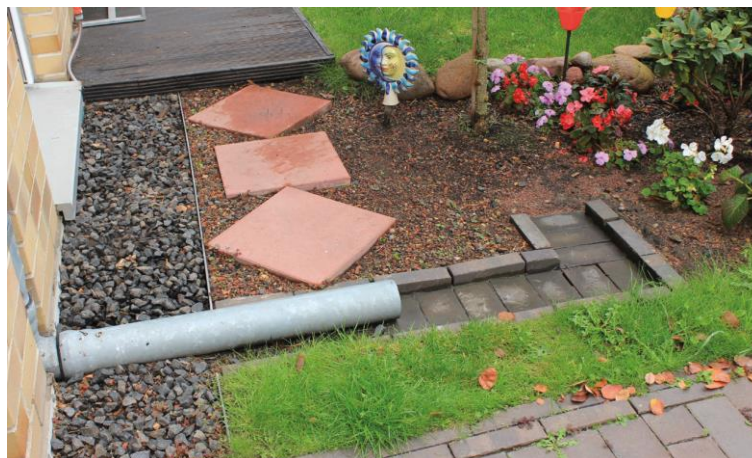
Fig. 3.13 – Frakopling av taknedløp [44]
