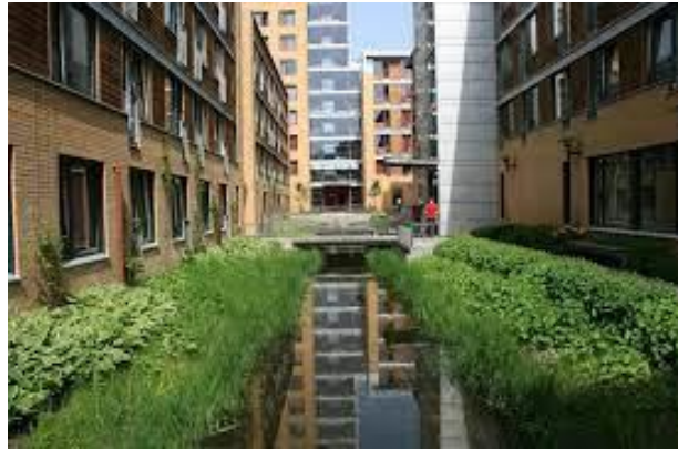
Fig. 3.24 – Vegetasjon i overvannshåndtering [62]
