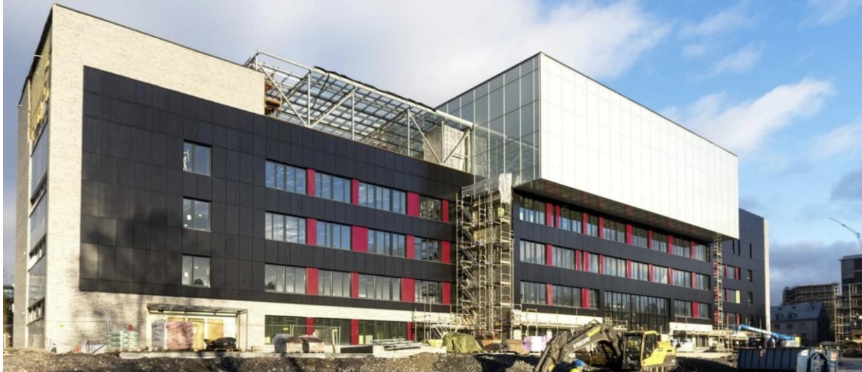
Figur 12: Bygningsintegreerte solceller på Brynseng skole i Oslo [52].
