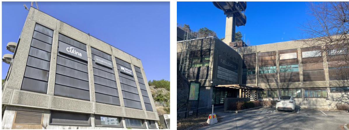
Figur 30: Bilder av ytterveggene til kontorbygningen i Banehaven 4A.
