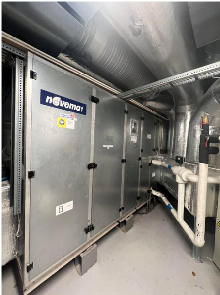
Figur 31: Ventilasjonsaggregatene i Banehaven 4A. Det til venstre er plassert i 2. etasje og det til høyre står på taket til 3. etasje.
