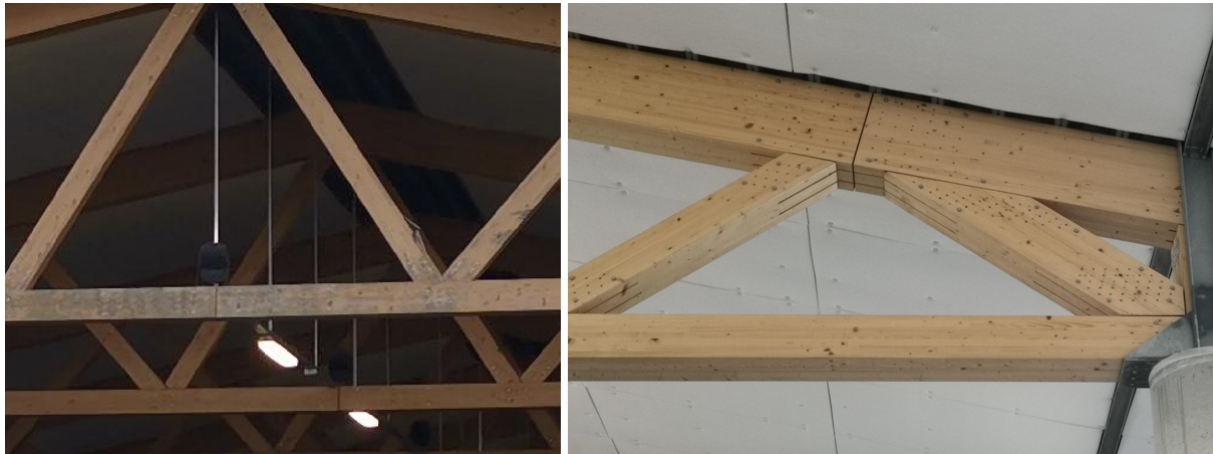
Figur 8.17 Fagverkets skjøter
