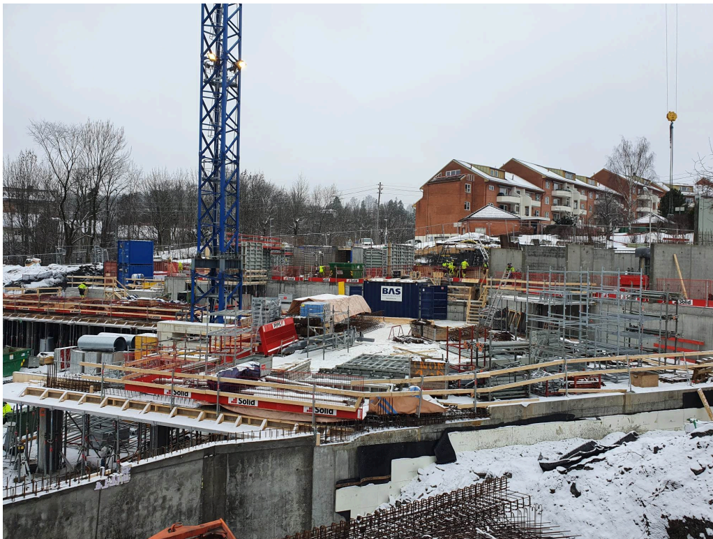
Figur 4.3: Bilde Hoffsveien Hage 07.02.2023
