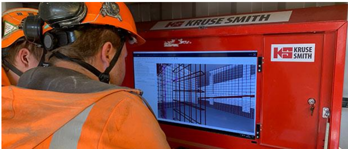
Figur 6: Illustrasjonsfoto av to arbeidere som bruker BIM-kiosken som produksjonsgrunnlag til armeringsarbeidet (Kruse Smith, 2022).
