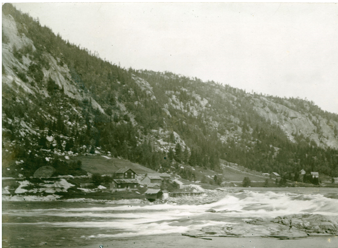
Bilde 3 Odden ved Fennefoss der haugianernes papirmølle i sin tid sto. Den langstrakte bygningen til venstre i bildet tjente som bolighus for arbeiderne ved mølla.
