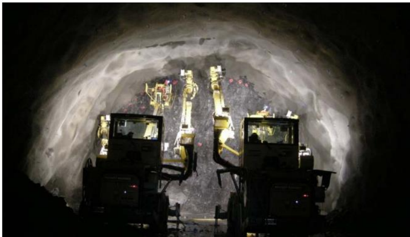
Figur 3.1 Boring av injeksjonshull i Bærumstunnelen, ref [31]
