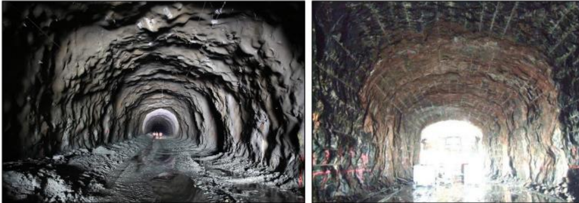
Figur 3.19 Bildet til venstre viser en ikke uvanlig kontur i en norsk samferdselstunnel, mens bildet til høyre viser en god kontur i en svensk forsøkstunnel
