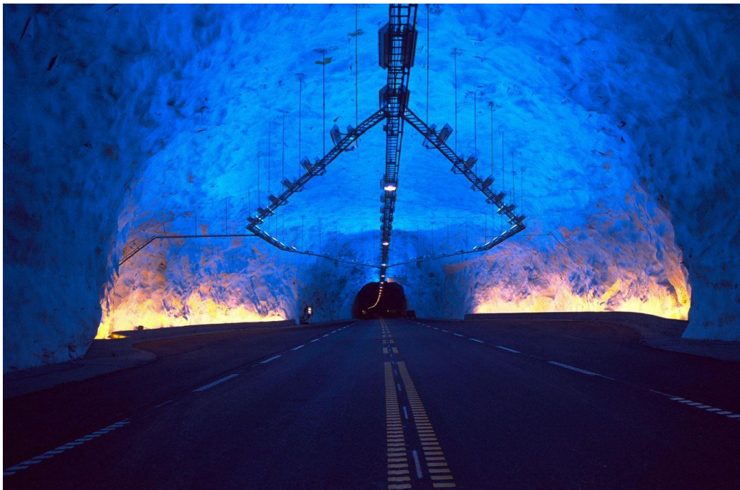
Figur 1.1 Verdens lengste vegtunnel, Lærdalstunnelen, ref [8]
