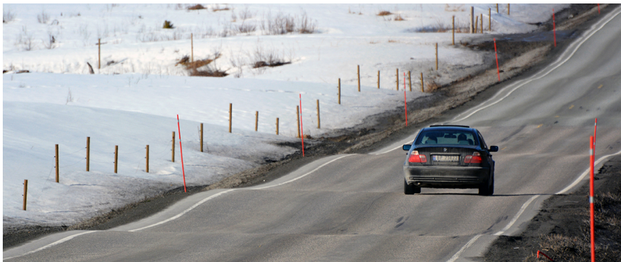
Figur 2.3: Telehiv forårsaket av feildimensjonert overbygning. Hentet fra Språkrådet [10].
