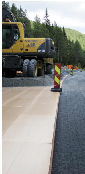
Figur 3.12: XPS-plater brukt som frostsikring. Hentet fra SVV [41].
