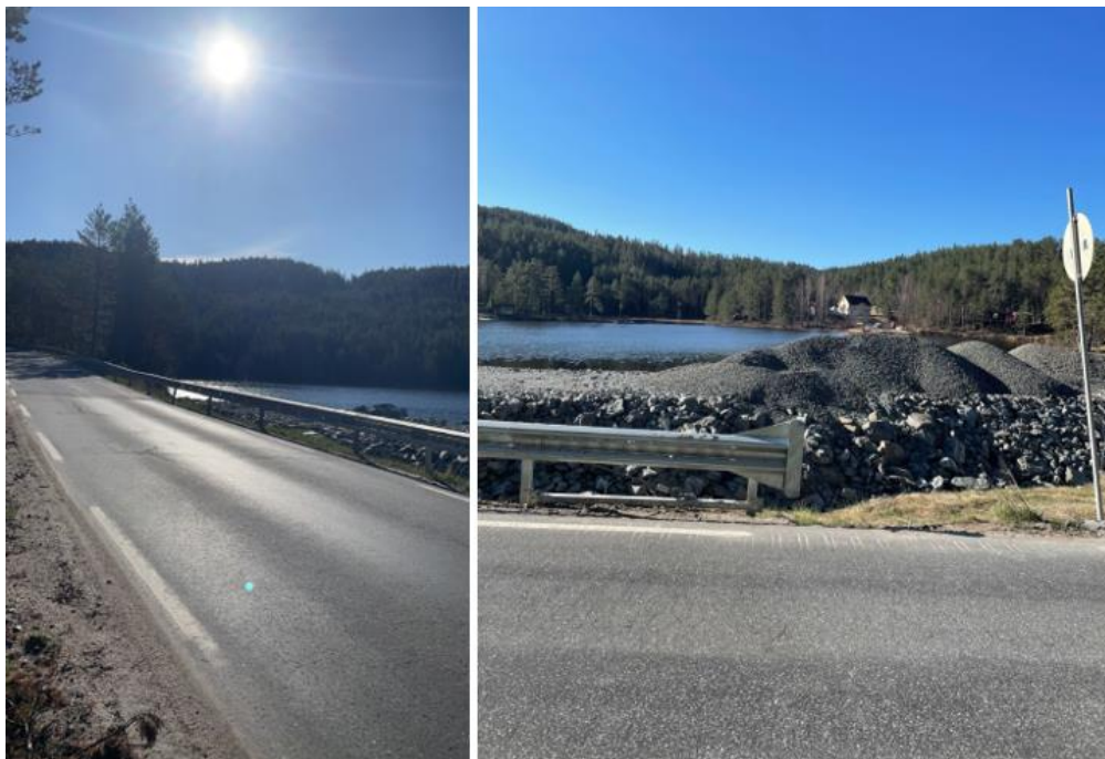
Figur 7-13 Vegen sett fra innløp DN 400 stikkrenne, bilde t.v. vegen retning Hynnekleiv og bilde t.h. fra innløp rett over vegen mot Guslåtjørna. [Foto: Kristian Kolstad, 29.04.2022]
