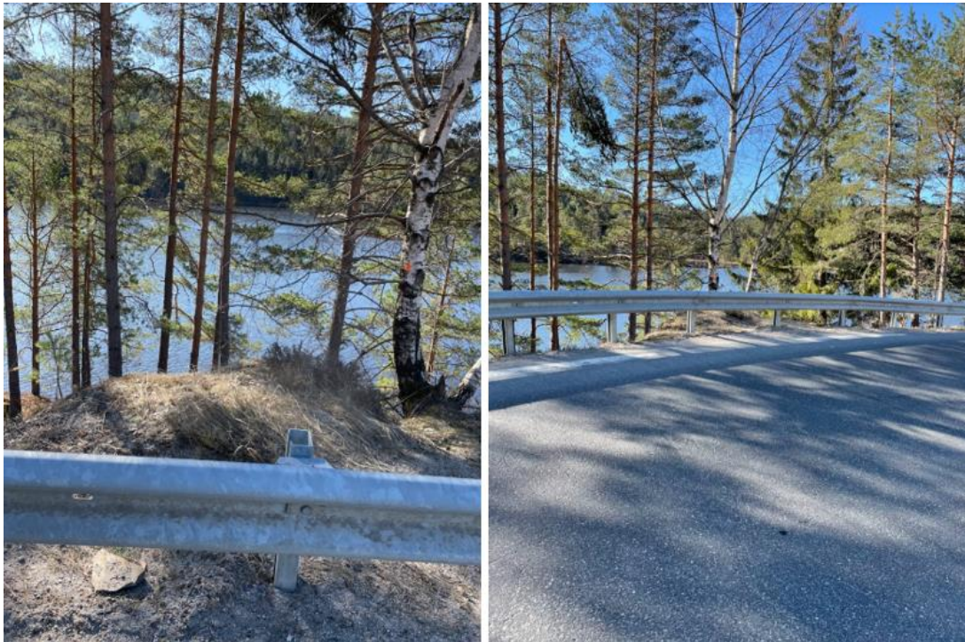
Figur 7-16 Fjell i dagen bak autovern i yttersving mot Guslåtjørna. [Foto: Kristian Kolstad, 29.04.2022]
