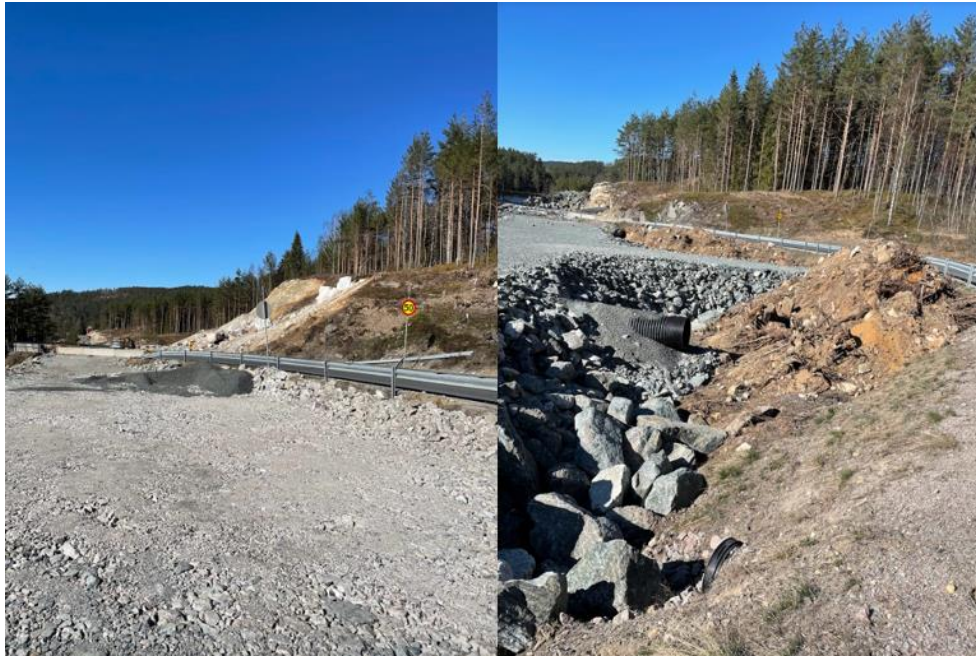
Figur 7-12 Bilder fra anleggsområdet. Begge tatt i retning Gauslå. [Foto: Kristian Kolstad, 29.04.2022]
