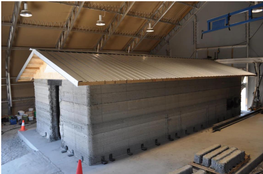
Figur 3-12: Komplet 3D-printet militærbrakke i betong med manuelt konstruert tak [39].
