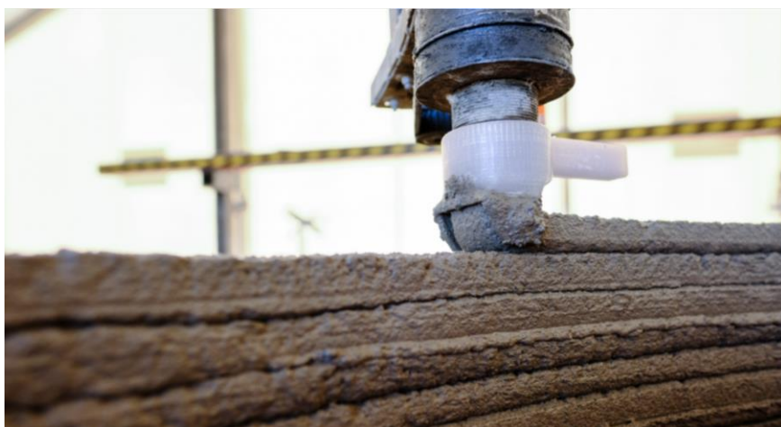
Figur 7-14: Gaffelutformet vertikal betongdyse [47].
