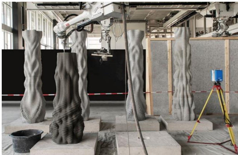
Figur 7-27: Printing av betongsøyler [77].
