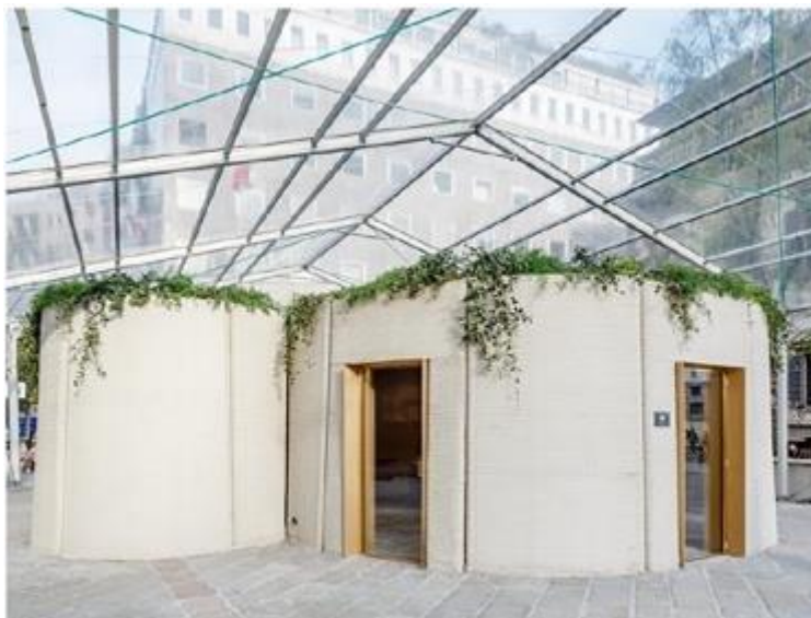
Figur 7-30: Ferdig preprodusert 3D-print av betongvegger på byggeplass [76].
