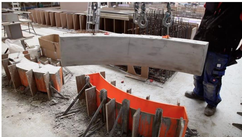
Figur 3-14: Støping av buet vindussegment i 3D-printet forskalingsform [43].
