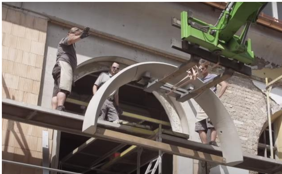
Figur 3-15: Ferdig sammensatt buet vindusramme klar til montering [44].
