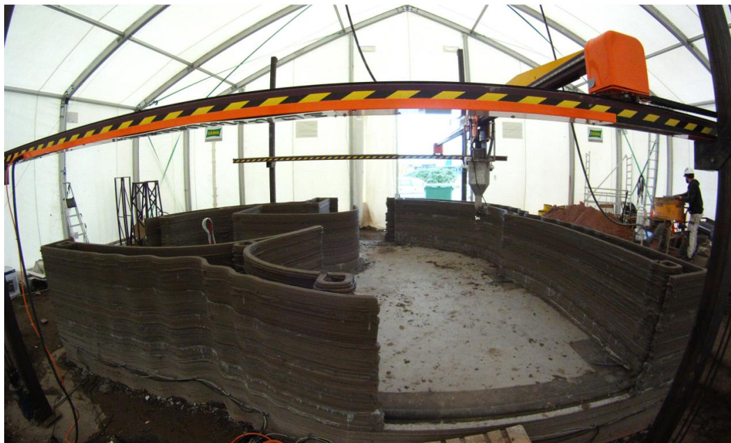
Figur 7-22: Påbegynt printing av betongvegger [74].
