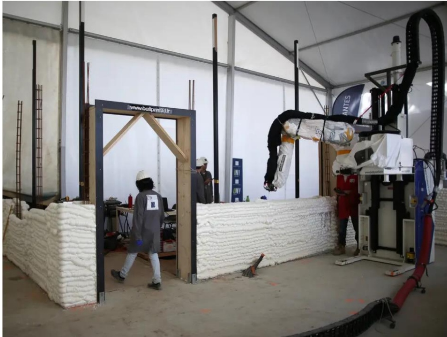
Figur 3-17: Byggeprogresjon tidlig byggefase [46].
