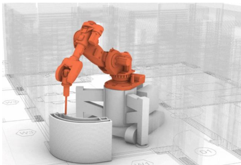
Figur 7-29: Preprodusert 3D-printet betongelement på byggeplass [78].
