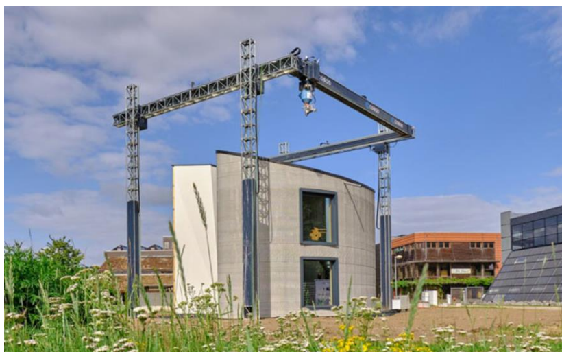
Figur 3-13: Komplet 3D-printet hus produsert med 3D-printeren, utviklet av «COBOD» [42].
