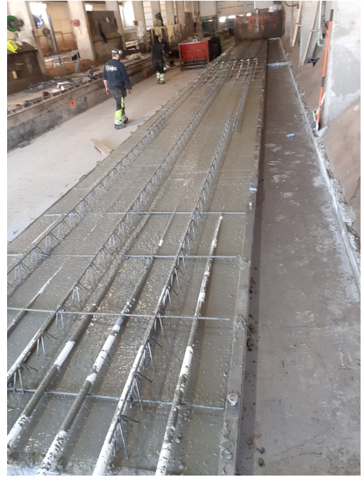
Figur 7.4: Ferdig støpt plattendekke
