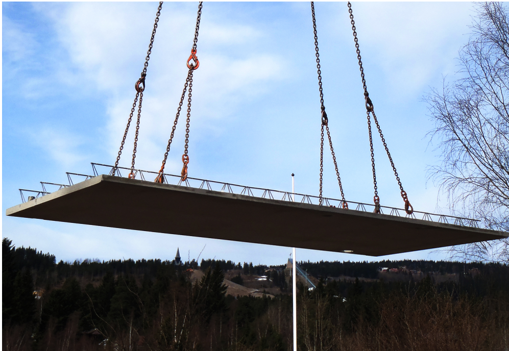
Figur 3.8: Plattendekke som løftes på plass [2]
