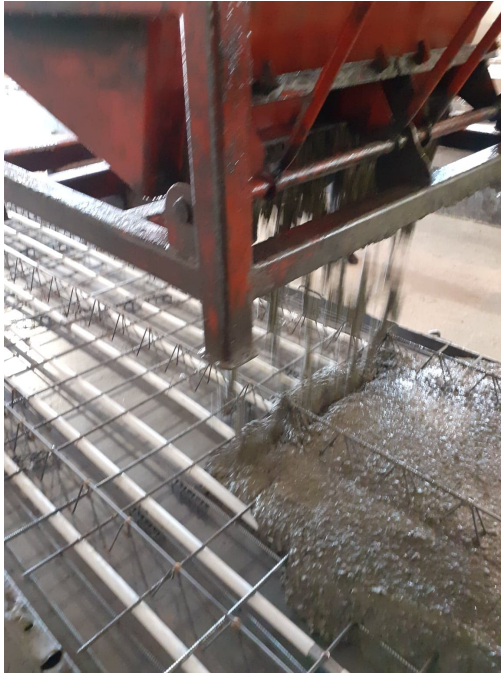
Figur 7.3: Utstøping av plattendekke
