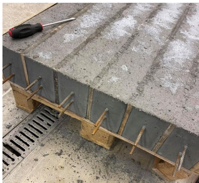
Figur 6.6: Demontering av kortsideplatene ved uthenting av bjelker. Privat foto
