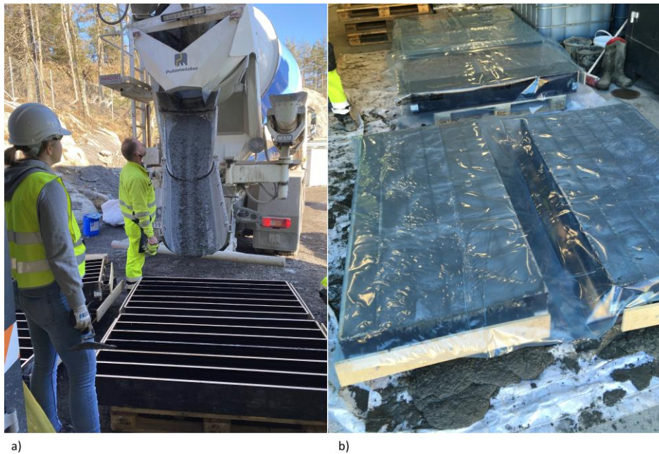
Figur 6.5: a) Støping av UHPC fra betongbil med renne og b) tildekking av testobjektene over natten. Privat foto
