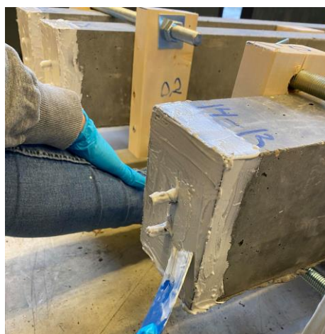
Figur 6.12: Påføring av første lag med epoxy. Privat foto
