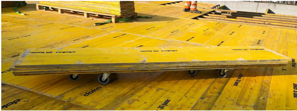
Figur 14: Tralle brukt for å redusere bevegelse ved flytting av materiell.
