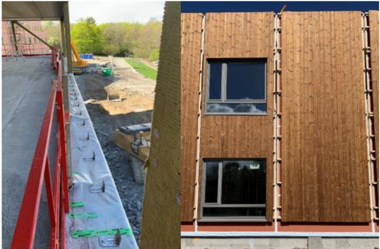
Figur 12-9 Feste av vinkler (tettingsarbeid) og utvendig komplementeringsarbeid
