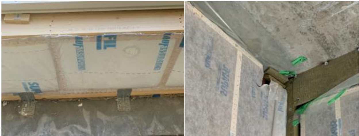
Figur 12-10 Eks på innvendig komplementeringsarbeid
