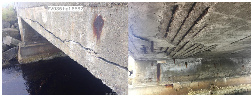
Figur 3.2: Illustrasjon av skadeomfanget slik Strauman 3 er i dag [Eget bilde]
