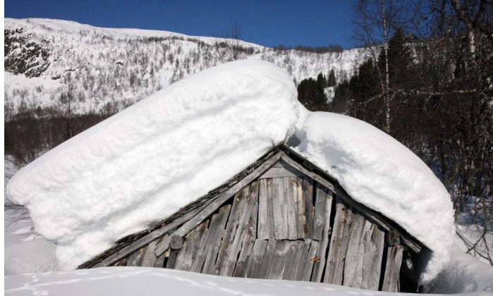
Figur 3.2-1 Skjevfordelt snølast [12].
