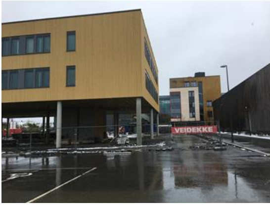
Nybygget og skolen sett fra vest
