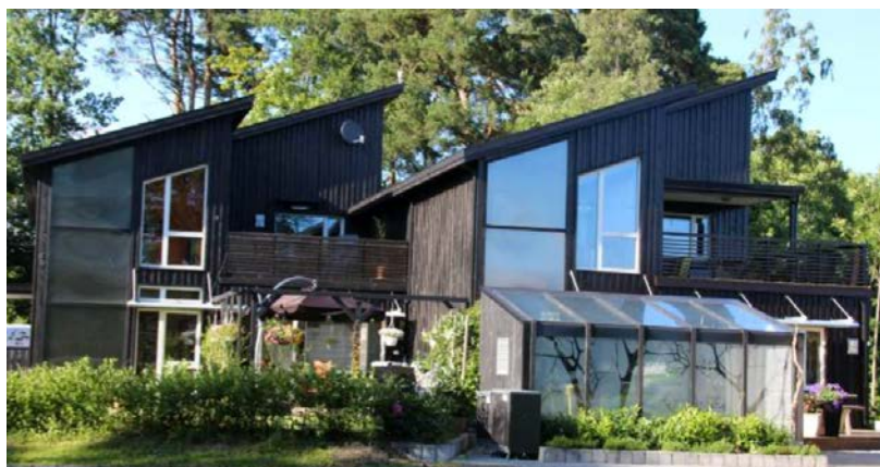
Figur 3.13 Passivhus med mekanisk og naturlig ventilasjon på Vessøya. Foto: Bengt. G. Michaelsen
