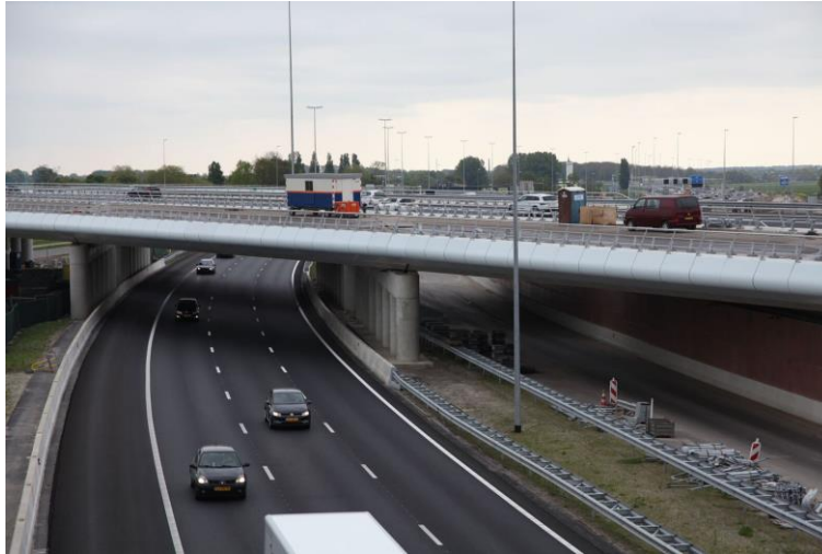
Figur 7.16: Prefabrikkert bro i Nederland med glassfiber kantelementer (Foto: John-Erik Reiersen, Betongelementforeningen)
