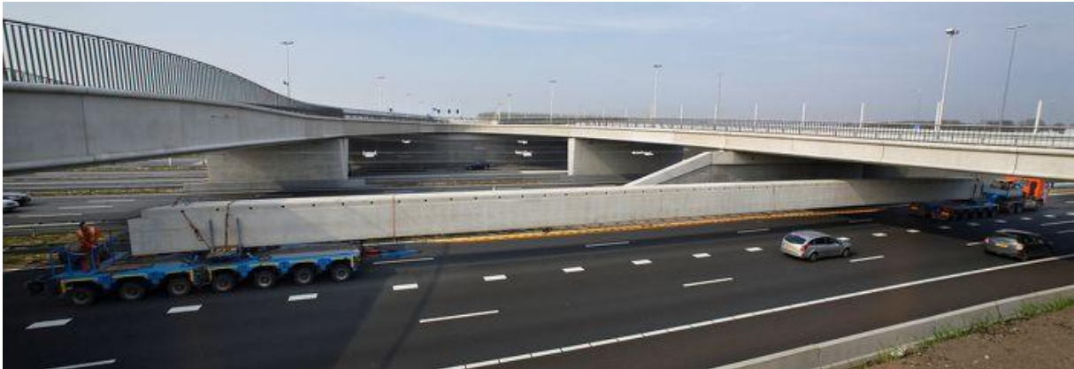
Figur 3.11: Transport av 60 meter langt broelement fra fabrikk til lokasjon [43]
