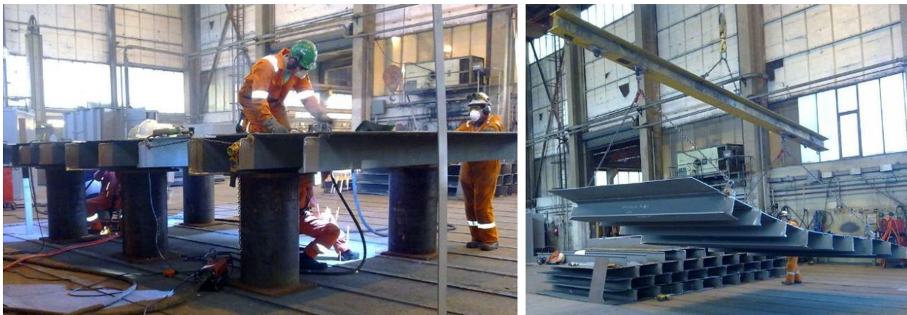
Figur 25: Fra sammenstillingshallen. Til venstre jobber 2 sveiserne på undersiden av modulen, mens 2 platemontører jobber rundt- og over modulen. Til høyre fraktes modulen til bufferlagring, slik at arbeid på ny modul kan startes.
