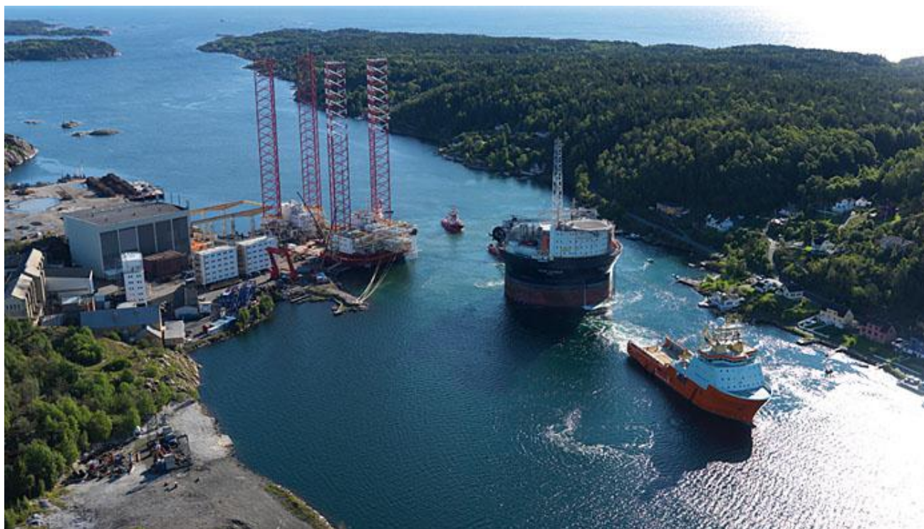
Figur 2: Produksjonsområdet i Eydehavn, Arendal til venstre i bildet. Bildet er tatt i en travel periode, med den oppjekkable riggen Haven liggende til kai samtidig som Sevan Voyager ble buksert inn.
