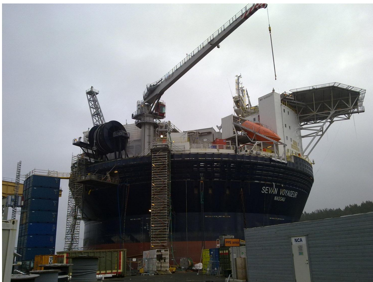
Figur 37: Sevan Voyageur ved kai i Eydehavn. Til venstre i bildet står det 8 containere stablet i høyden - heissystemet er montert utenfor disse. De 2 stillassystemene til høyre for heisen er trappesystemer. Uansett om hvilken rute som velges er det en tidkrevende prosess å ta seg opp / ned fra riggen.
