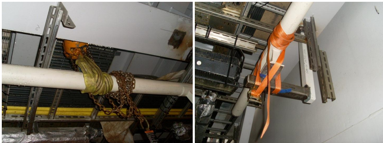
Figur 30: Eksempler på making-do. Venstre: Bruk av taljer og løftestropper kompensere for manglende opplegg (support). Høyre: Jekkestropper holder røret på plass som en midlertidig løsning.
