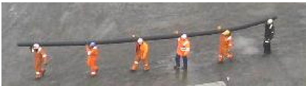
Figur 32: Eksempel på making-do ved manglende tilgang på kran.
