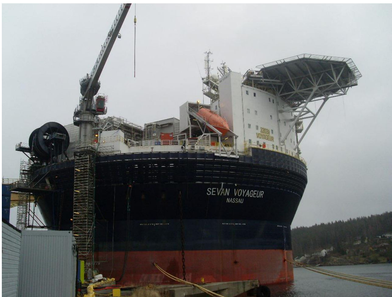
Figur 3: Sevan Voyageur til kai i Eydehavn. Dette er en FPSO-plattform der Nymo har fått oppdraget med å utføre en andre gangs oppgradering.
