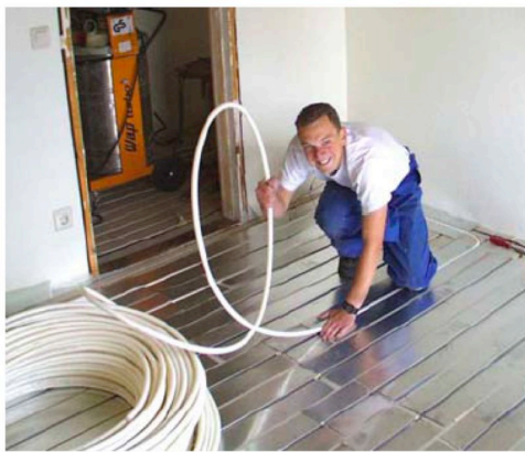
Figur 23: Legging av gulvvarmerør i profilerte aluminiumsplater og eksempel på utforming av lett gulvvarmeanlegg i mellombjelkelag [Gundersen 1998, 22]
