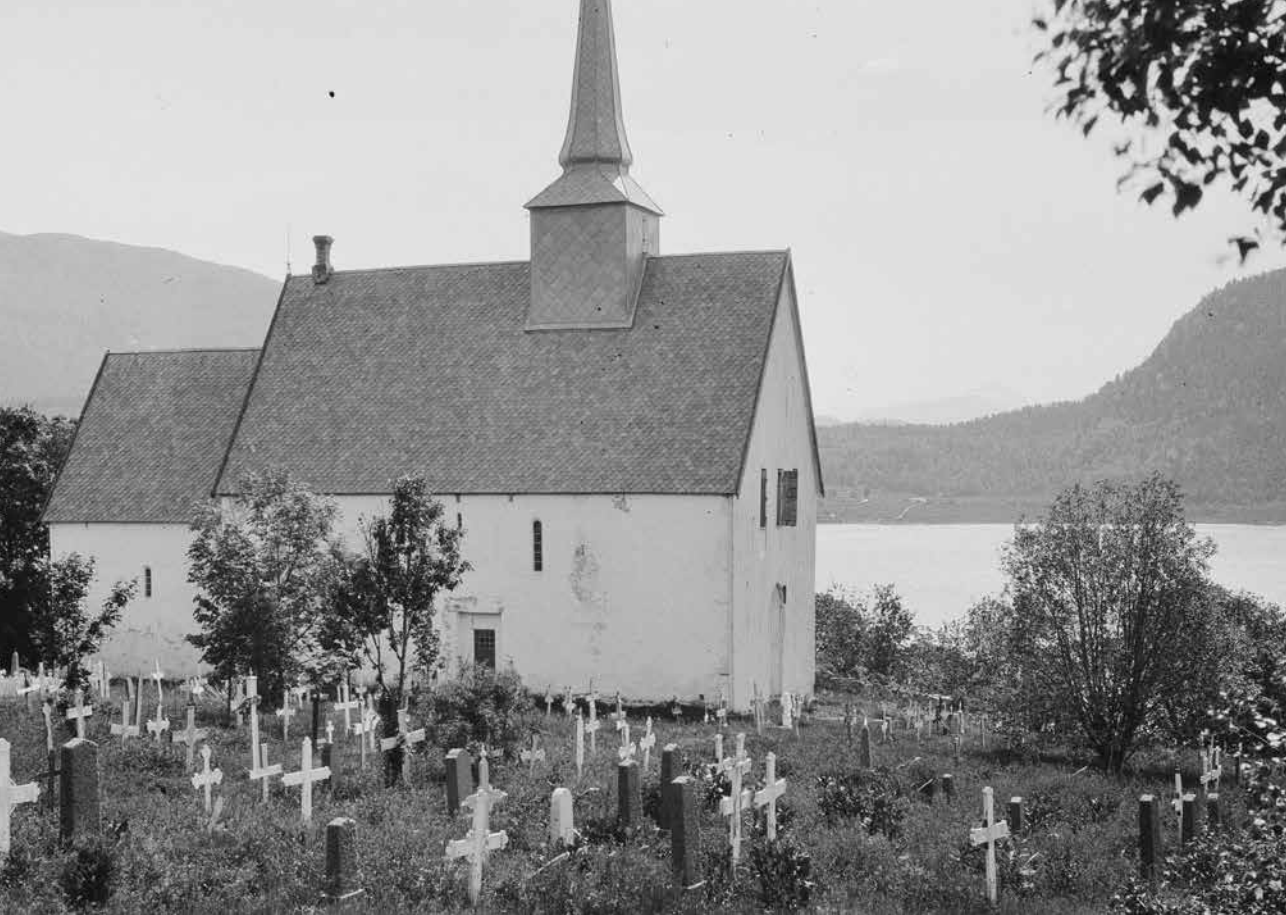
Fig. 14. Tingvoll kirke 1920. Gravplassen fremstår som en frodig eng. Fra Nasjonalbiblioteket. Foto: Riksantikvaren, 1920
