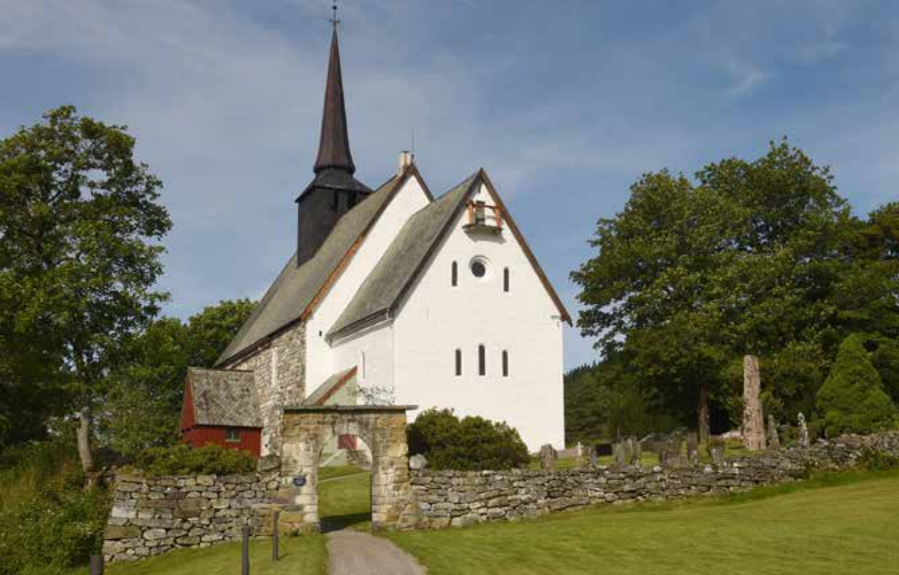
Fig. 13. Tingvoll kirke på Nordmøre. Inngangsparti til kirkegården. Porten er gjenbruk av åpningen i lektoriemuren som ble revet i 1878.
