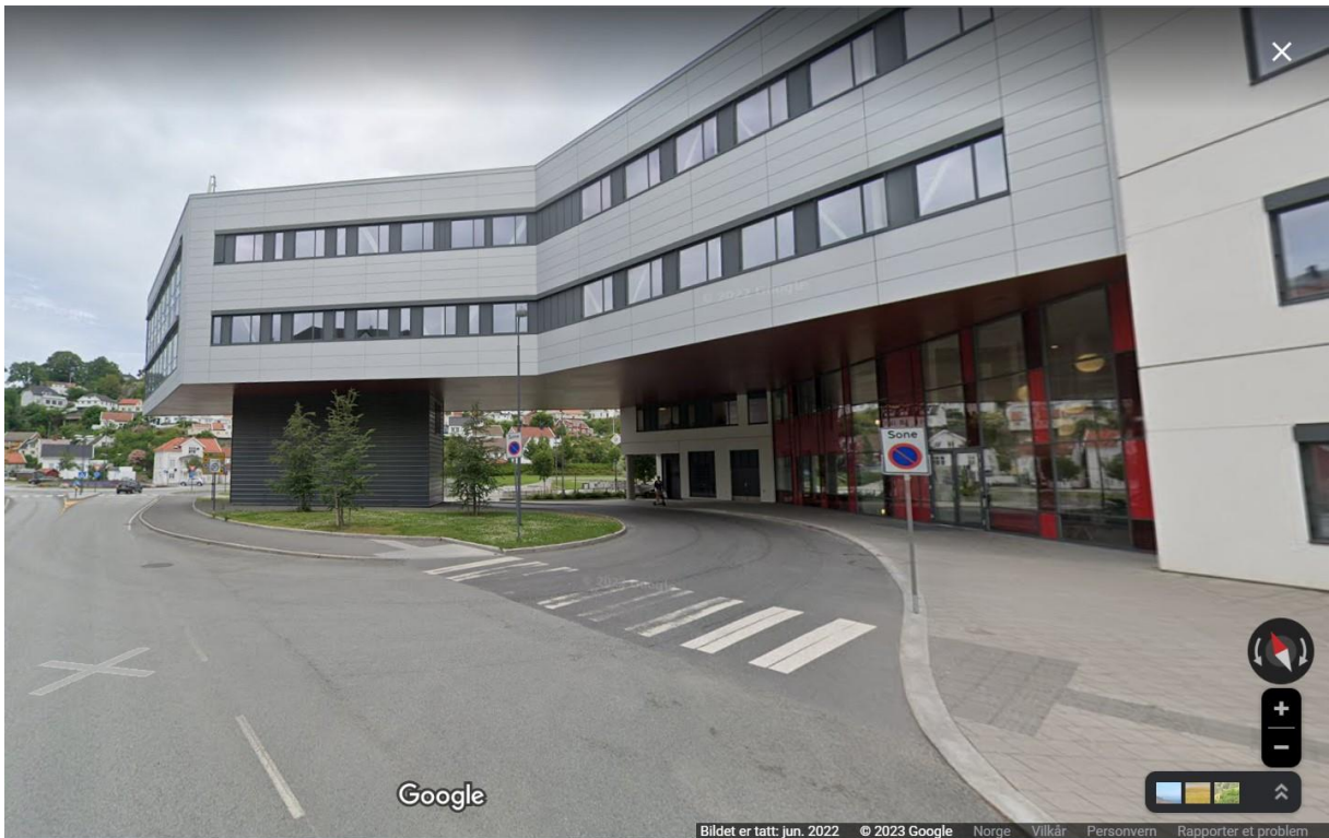
Figur 8.5: Skjermdump fra googlestreetview av bygning som ikke ble lagt riktig inn i modellen
