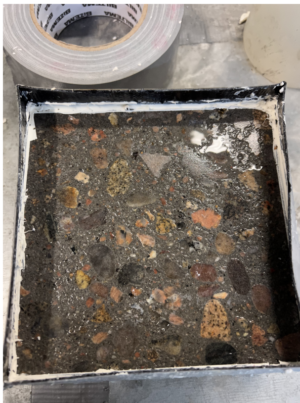
Figur 7.12: Overflaten til den grå betongen etter 56-sykluser.
