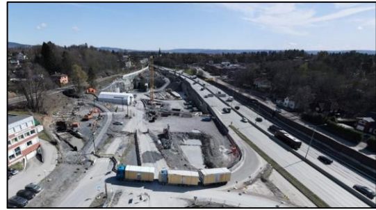
Figur 4.1: Anleggsarbeider på Ramstadsletta, mai 2023. (Foto: Sofia Gavidia-Ascario). [25]
