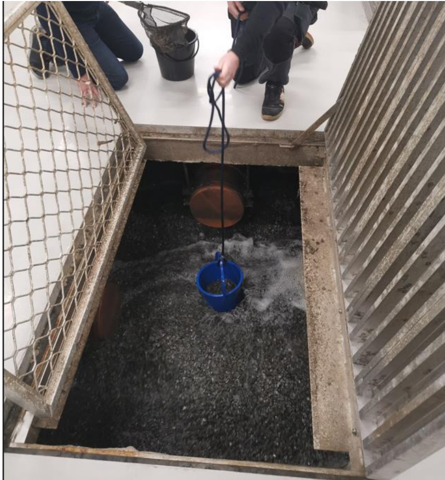
Figur_6.1: Her demonstrerer en driftsoperatør hvordan vannet skal hentes ut og hvordan det skilles ut små plast-biter. Under i bassenget ser vi masse små plastbiter som blir blåst opp av luftbobler.
