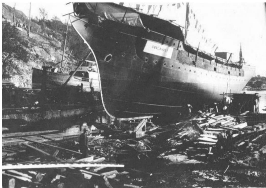
Skoleskipet «Sørlandet» under byggingen på Høivolds Mekaniske Verksted.
