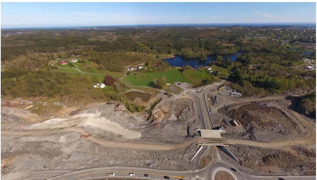
Fig. 1 The Stølen site in E18 Arendal-Tvedestrand May 2018
