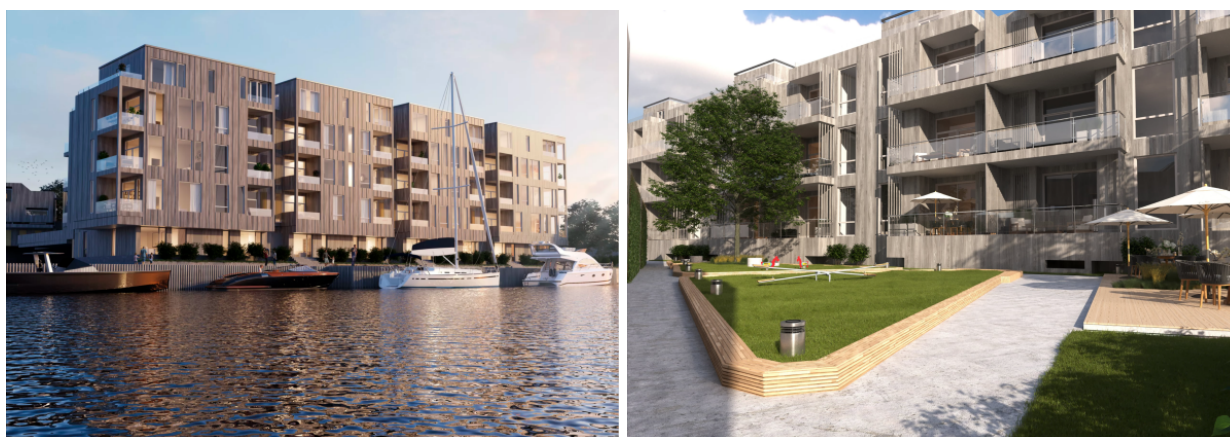
(a) Hovedbygget - fasade mot nord
