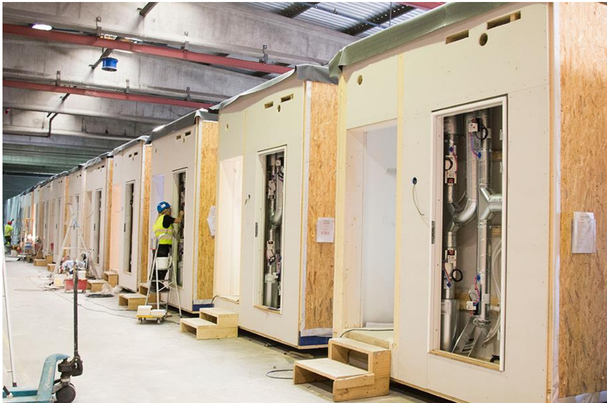
Figur 3-5 Moduler under produksjon hos Skanska husfabrikken [32]
