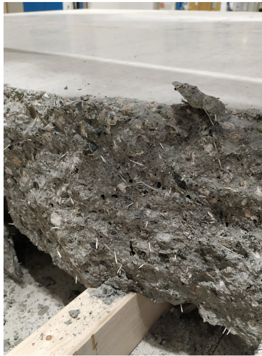
Figur 7.41: Veggelement med fiberarmering etter brudd. [6]
