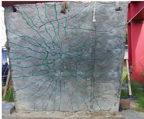
Figur 7.21: Rissmønster på undersiden av det stangarmerte fundamentet etter gjennomlokkingsbrudd. [61]
