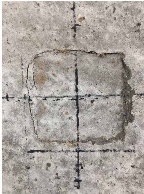
Figur 8.1: Overside av stangarmert fundament etter trykkbrudd. [1]
