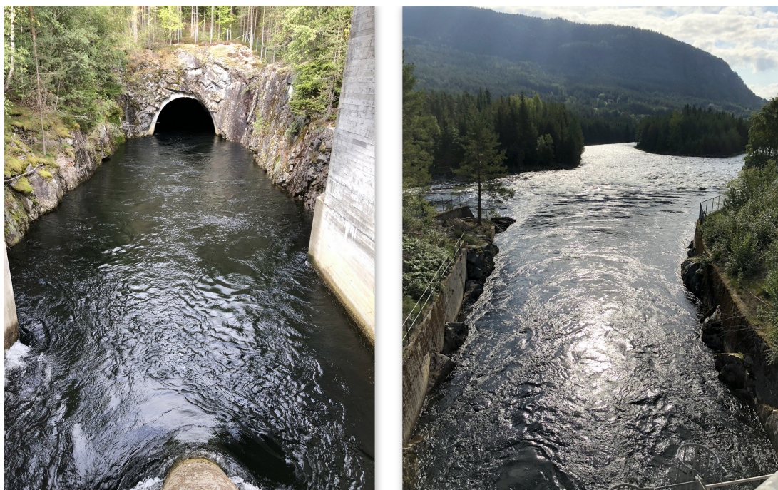
Figur 4.3: Foto tatt fra midtsøyle opp mot utløpstunnel (venstre) og ned mot Otra (høyre)
