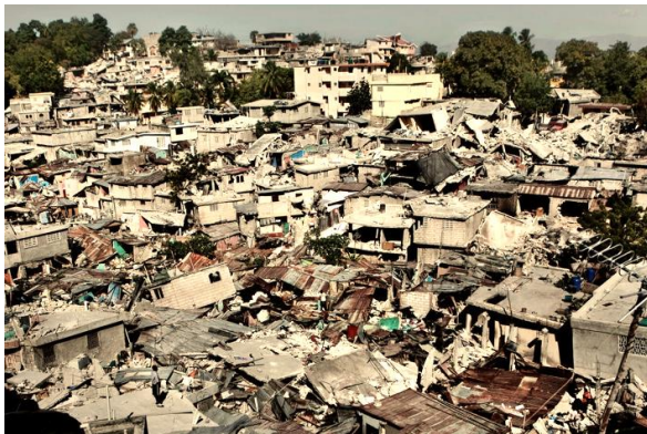
Figur 2-1: Ødelagte infrastrukturer etter jordskjelv i Haiti [37]
