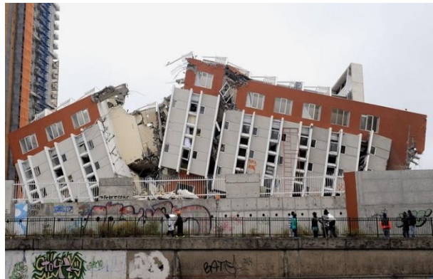
Figur 2-2: Delvis ødelagt bygg etter skjelvet i Chile [38]
