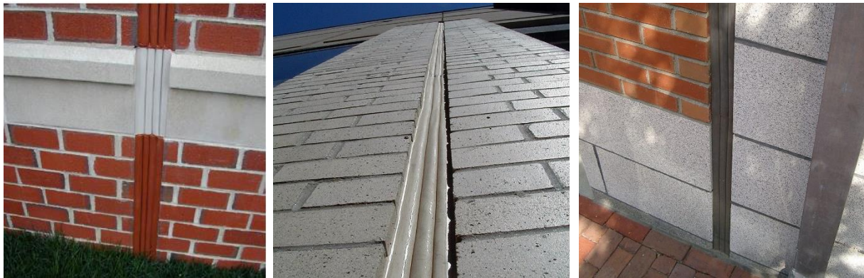
Figur 3.3.1-2: Illustrasjon av seismiske fuger [16]
