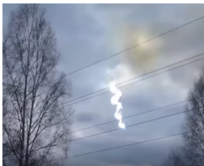
Figur 2.10. Illustrasjon av lysbue oppstått mellom flere faser.
