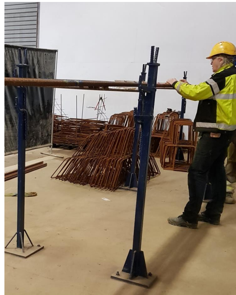
Figur 5-6: Armeringsstenger kappes manuelt [11].
