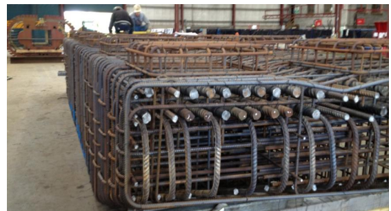
Figur 8-4: Armert etter BIM modell [43].
