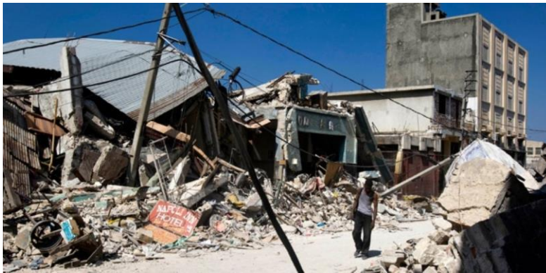
Figur 2.1: Kollapset bygning, Haiti [1]
