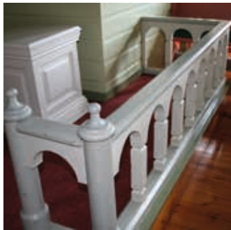
4 – Rekkverket mot koret
