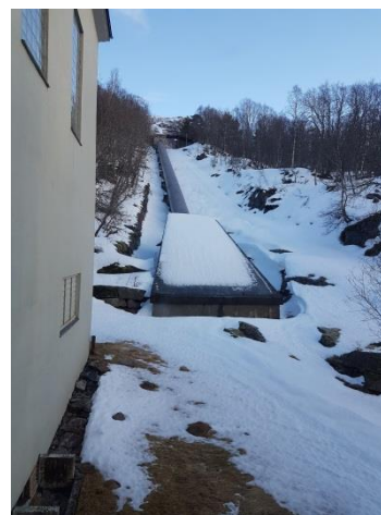
Figur 2 Rør gate som supplerer fra magasin Torfinnsvatnet
