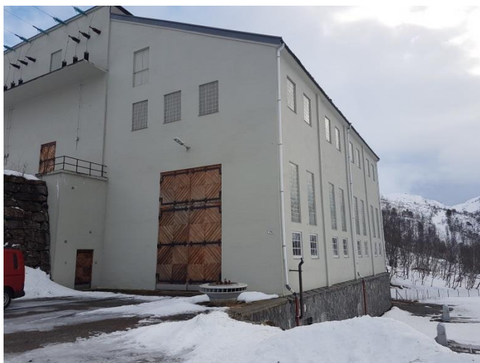
Figur 1 Utvendig Hodnaberg kraftstasjon
