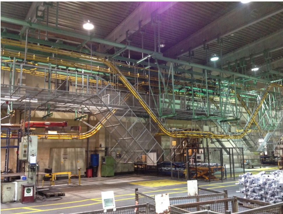
Bilde 1. Viser loadingstation hvor sandkjernene kommer på hengebanen. På oversiktsbildet er dette punkt 1.
