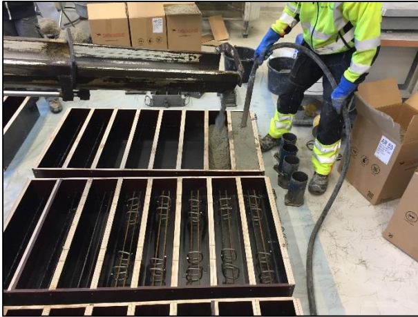
Figur 5-10 Utstøpning av første støperunde
