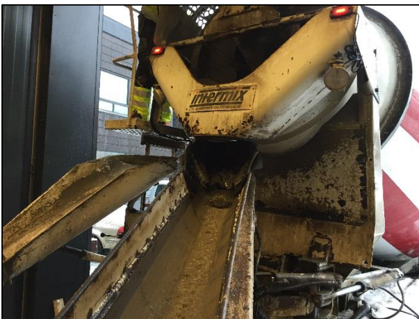
Figur 5-11 Utstøpning av andre støperunde
