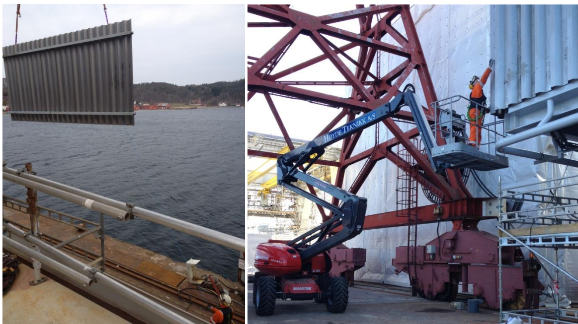
Figur 28: Montering av paneler/vindvegger på riggen.
