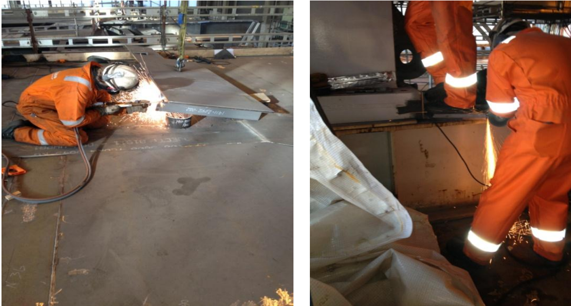
Figur 24: Til venstre: Operatør må gjøre tilpasninger på et stålelement. Til høyre: Operatørene kompenserer for manglende verktøy. En form for sløsing kalt making-do.
